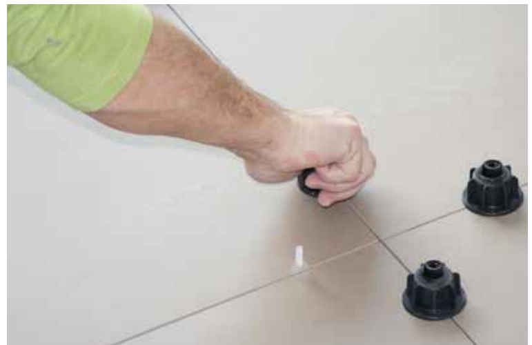
4. Zughaube auf Gewindelasche schrauben und mit wenigen Umdrehungen die Fliese auf das gewünschte Niveau anheben
